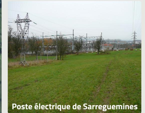
Pour pouvoir alimenter l'usine de panneaux photovoltaïques, RTE devra créer une nouvelle cellule dédiée à HoloSolis au sein de la partie 225 000 volts du poste. Cette cellule sera composée d'organes de coupures et de séparation (les disjoncteurs et les sectionneurs), d'appareils de mesures et de systèmes de protection.
